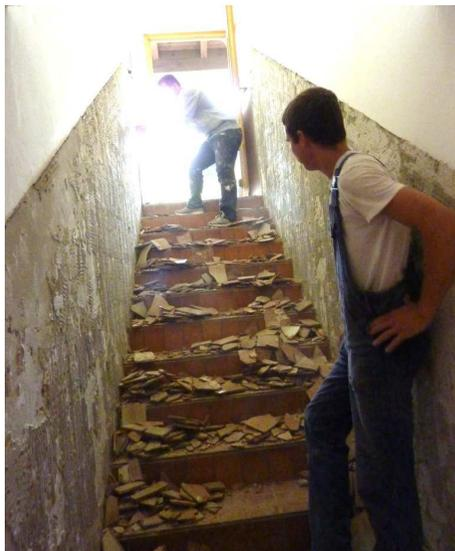
hatte die Sanierung der Kellerräume, in denen die beiden Gästekabinen, Toiletten sowie die Heimkabine untergebracht sind. „In den vergangenen sechs Wochen haben wir diesen Bereich entkernt, die Sanitärinstallation erneuert, eine zentrale Lüftungsanlage eingebaut und die Duschen neu gefliest. Durch die Neugestaltung der Wände, Decken und der Möblierung erscheinen die Kabinen nun in einem zeitgemäßen Aussehen“, schildert 2. Abteilungsleiter
